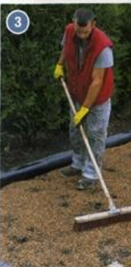
La première passe de bitume fixe le gravier de recouvrement
